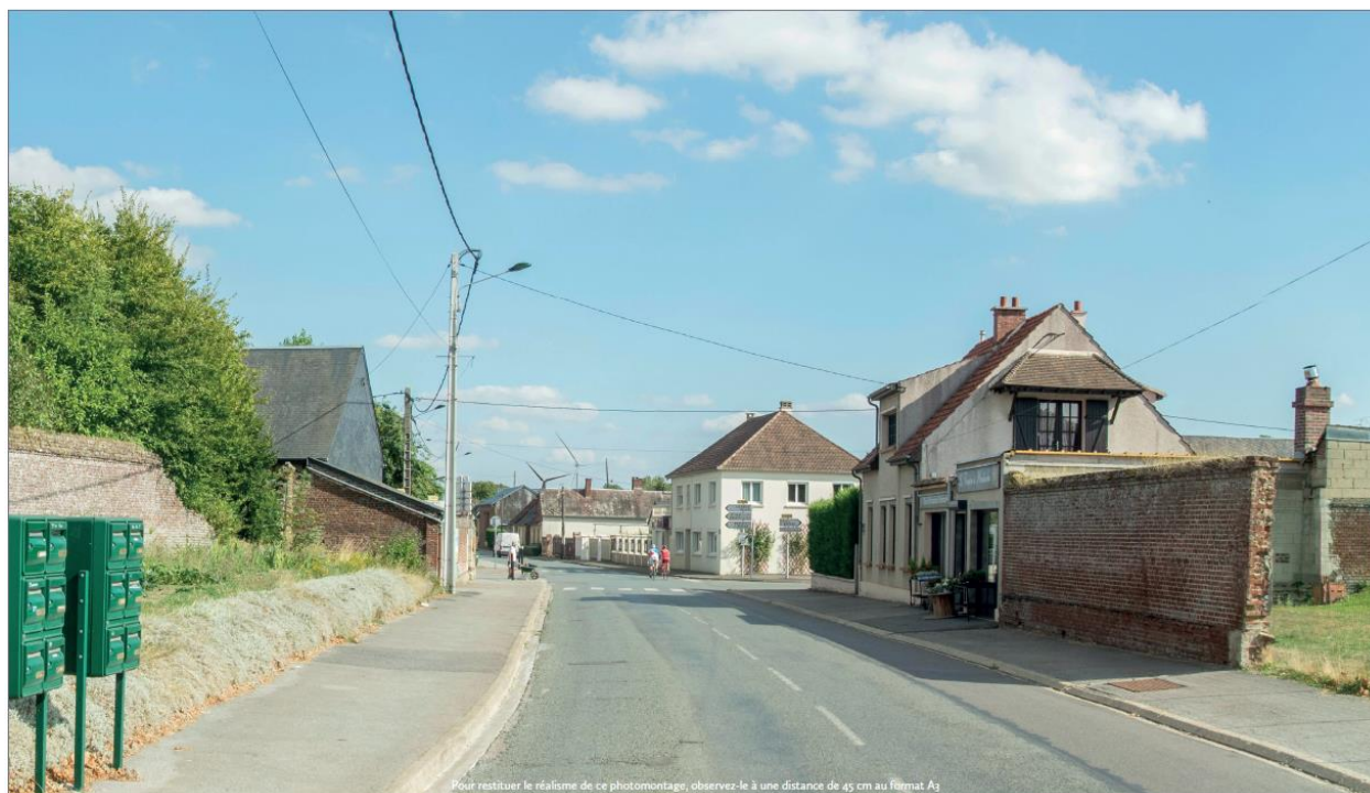
Photo 12: NOYERS-SAINT-MARTIN - Centre-bourg - Après renouvellement
