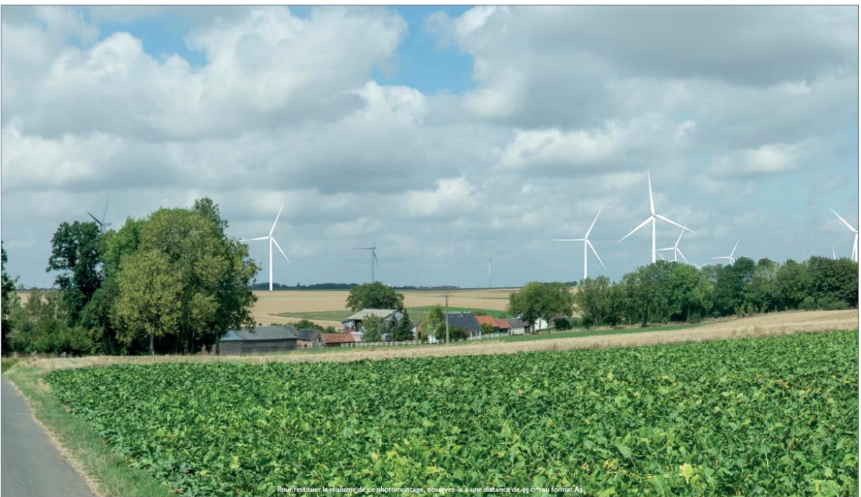
Photo 9: FRESNEAUX - Entrée est par une route locale - Après renouvellement
